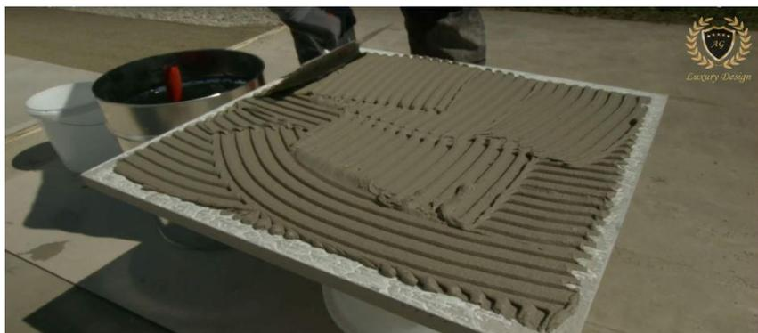
Bevor die Platten auf den Premium Monokorn Fixbinder verlegt werden können, wird auf jede Platte vorab AG-N Flex Spezial Kleber aufgetragen.
