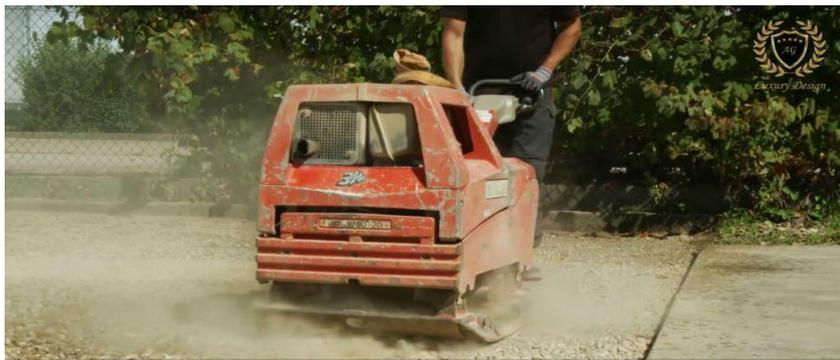
Zur Vorbereitung des Untergrundes wird die zu verlegende Fläche mit einer Rüttelmaschine verdichtet.
