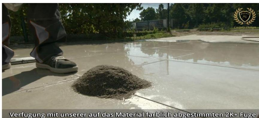
Im Anschluss an die Verlegung der Terrassenplatten wird die Gesamtfläche mit unserer speziell entwickelten 2K High Tech Fuge, speziell für den Außenbereich, verfugt.
