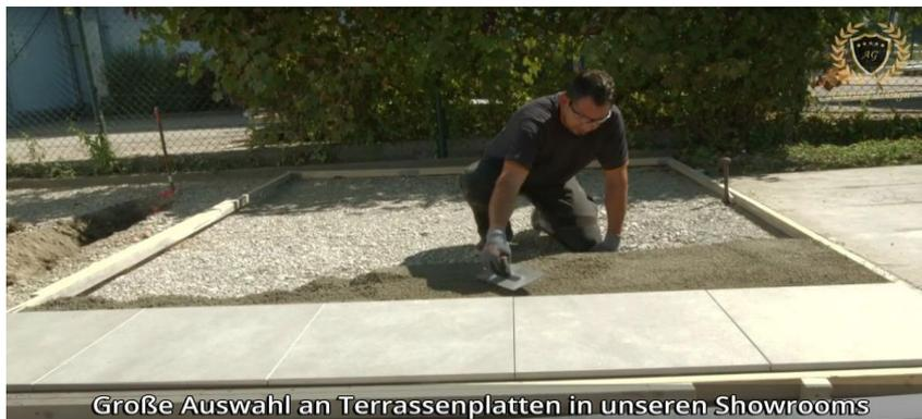
Die gesamte Fläche ist mit der vorbereiteten Masse auszufüllen und mit der Abzugsleiste glatt zu streichen. Hierzu wird ein Spachtel oder ein T-Profil empfohlen.
